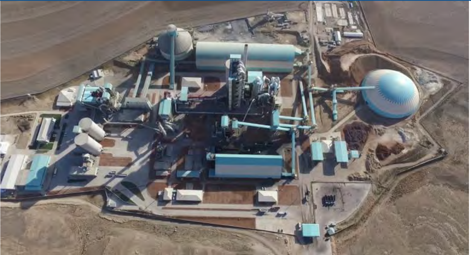
Preblending & Katkı Stokholleri- 2016 – Ankara - TÜRKİYE 17.000 + 12.000 m 2 Açıklık 55 mt & Çap 100 m
