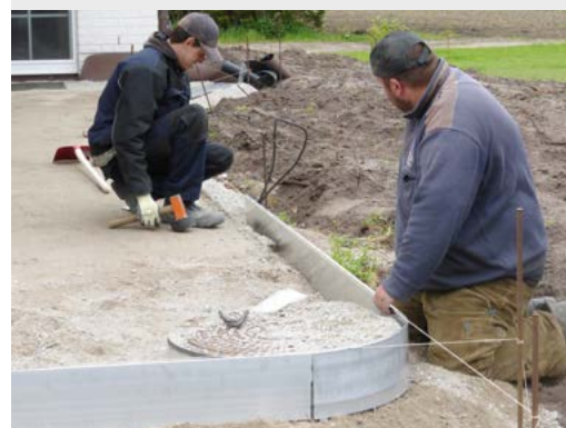
Profile with concrete/ground anchor سكة مع مرسة خرسانية وأرضية
